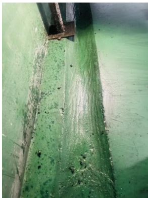
危废暂存库地面防腐及导流沟
